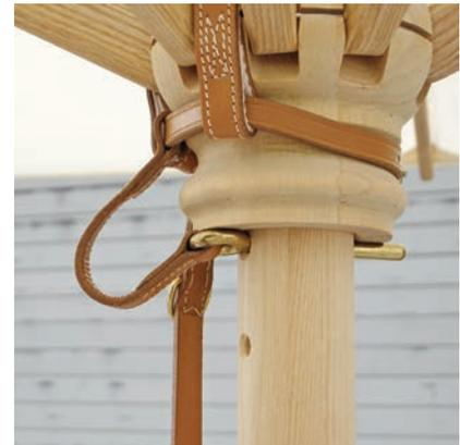
6. Haltestift ganz durch die Bohrung stecken.
